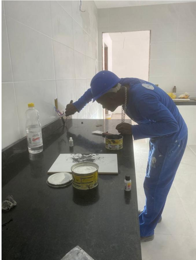
Fig. 19 : Execução de assentamento de bancada
