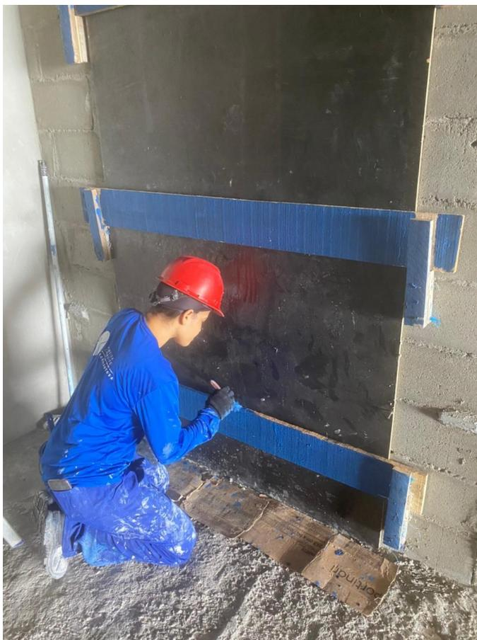
Fig. 13 : Execução de pintura das proteções dos elevadores
