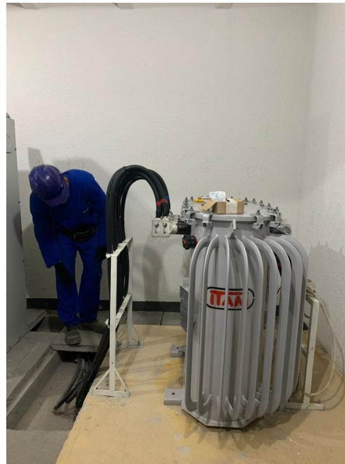
Fig. 18 : Instalação de cabeamento da subestação
