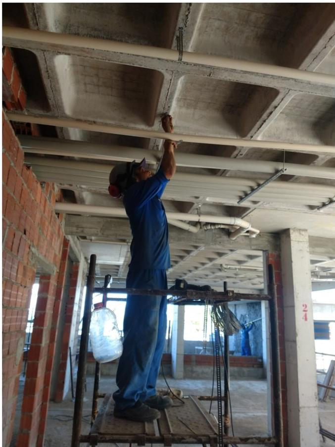
Fig. 17 : Instalação de fita perfurada
