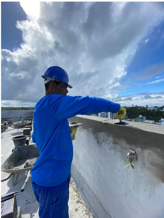
Fig. 21 : Execução de arestamento de platibanda
