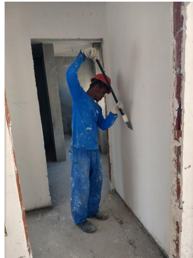
Fig. 04 : Execução de lixamento
