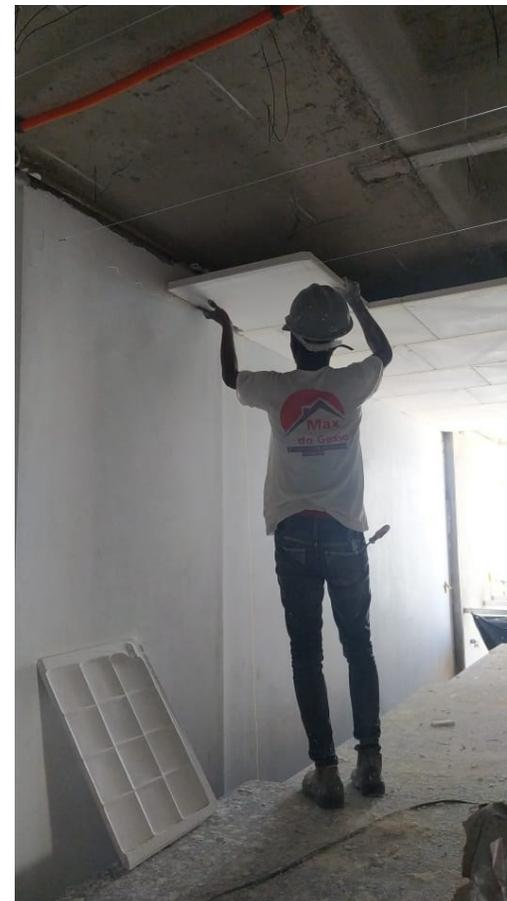
Fig. 06 : Execução de forro de gesso
