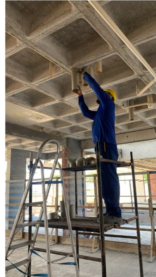
Fig. 10 : Instalação de prumada de esgoto
