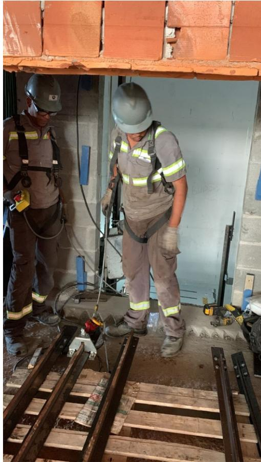
Fig. 15 : Instalação de elevador de serviço
