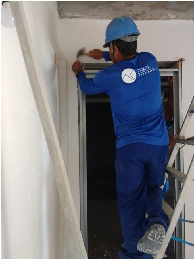
Fig. 07 : Instalação de porta
