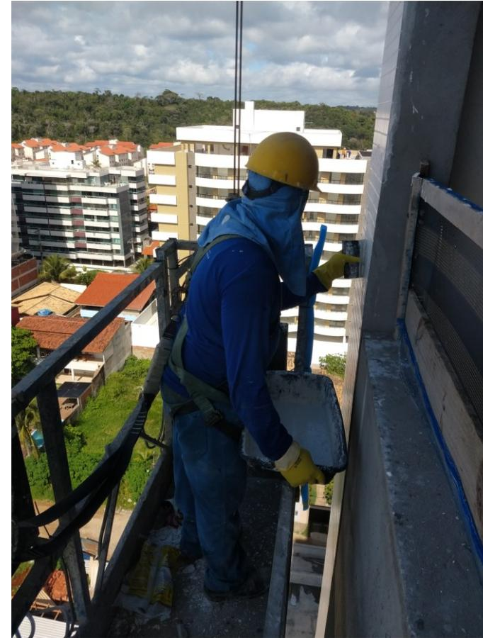
Fig. 16 : Aplicação de rejuntamento de fachada
