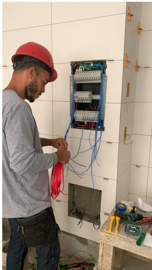
Fig. 11 : Execução de montagem de quadro
