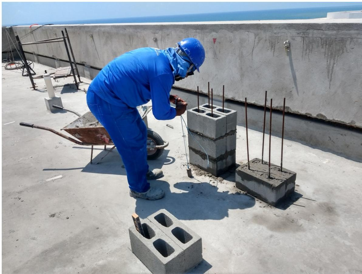
Fig. 12 : Execução de base para placas fotovoltaicas
