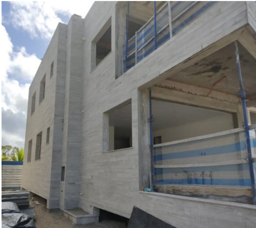
Assentamento de revestimento externo – BL4
