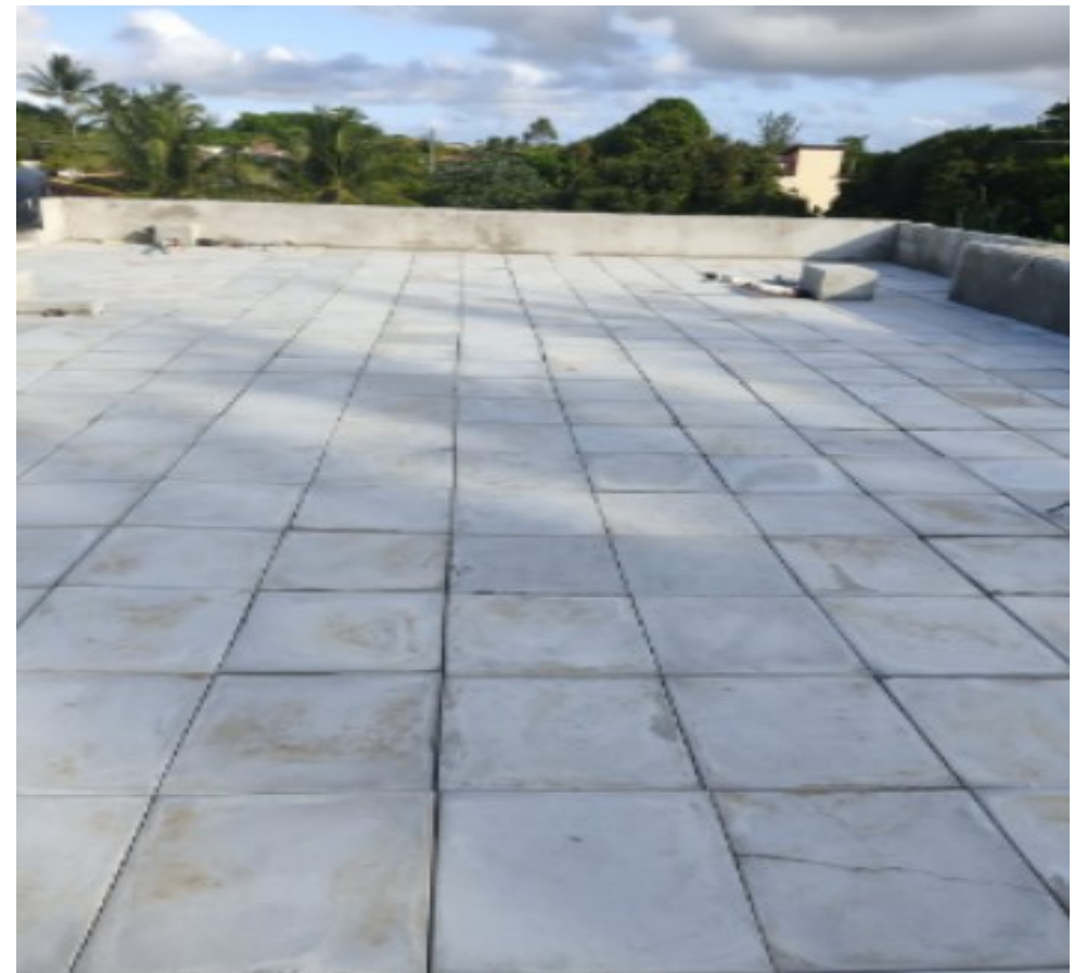
Instalação de lajotas - BL01
