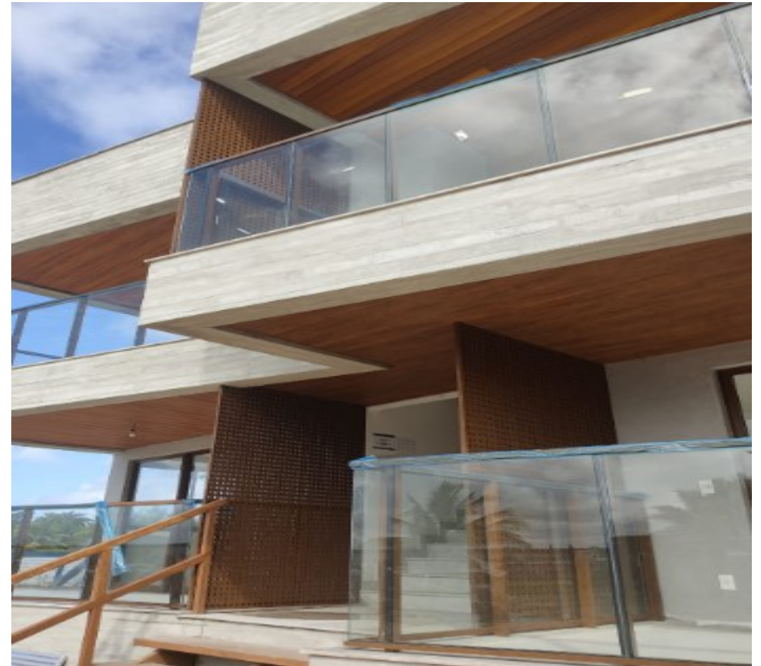
Instalação de Muxarabi - BL6
