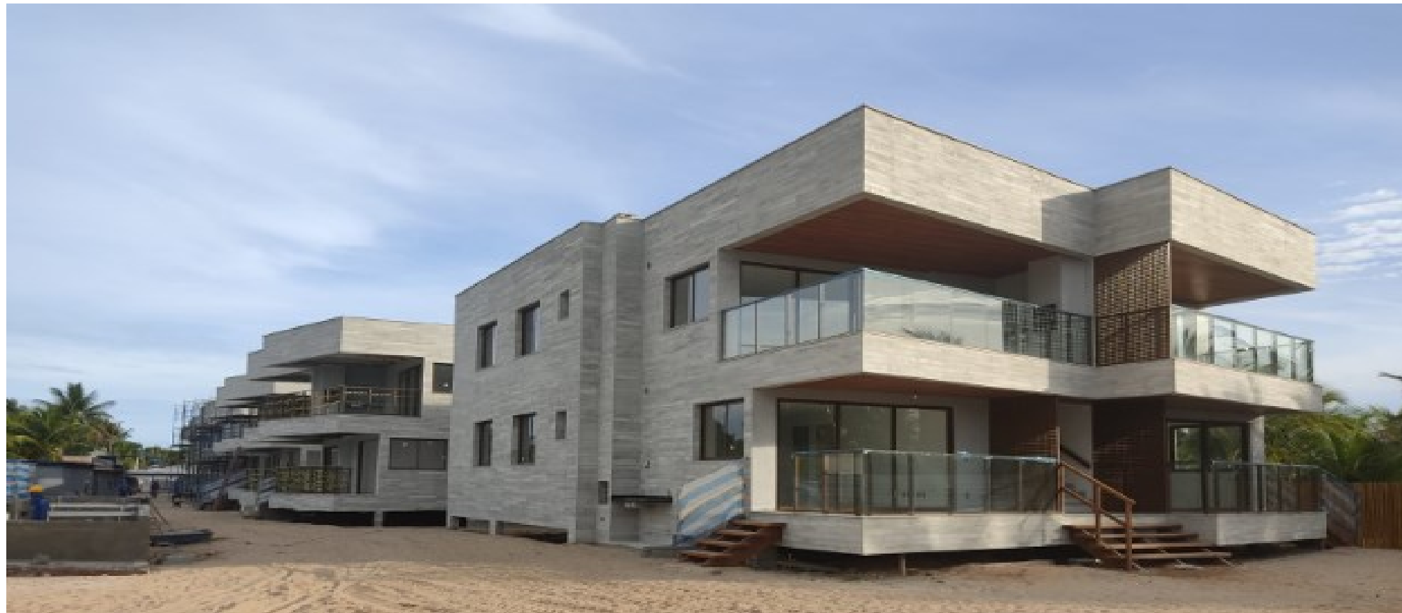
Vista panorâmica, iniciando pelo bloco 6
