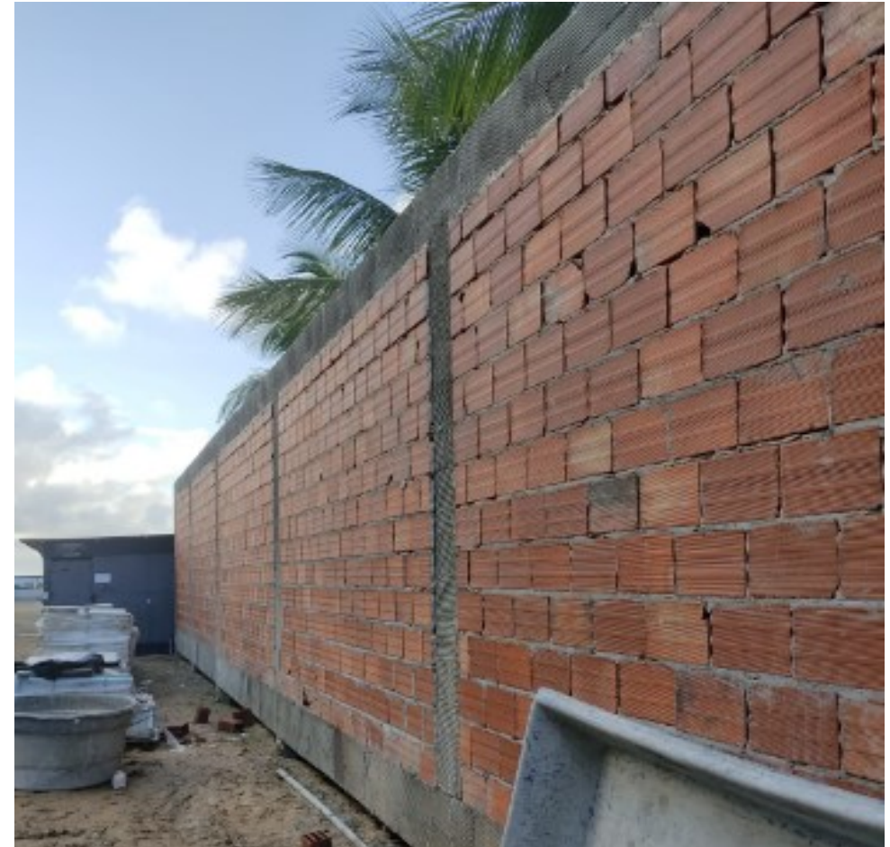
Alvenaria em Área Técnica
