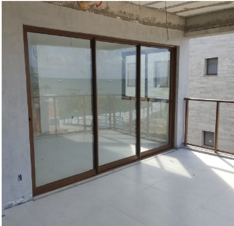
Instalação de esquadrias em BL - 5
