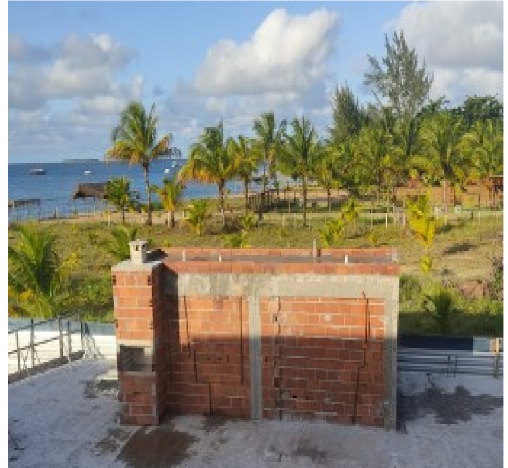
Alvenaria Área Gourmet
