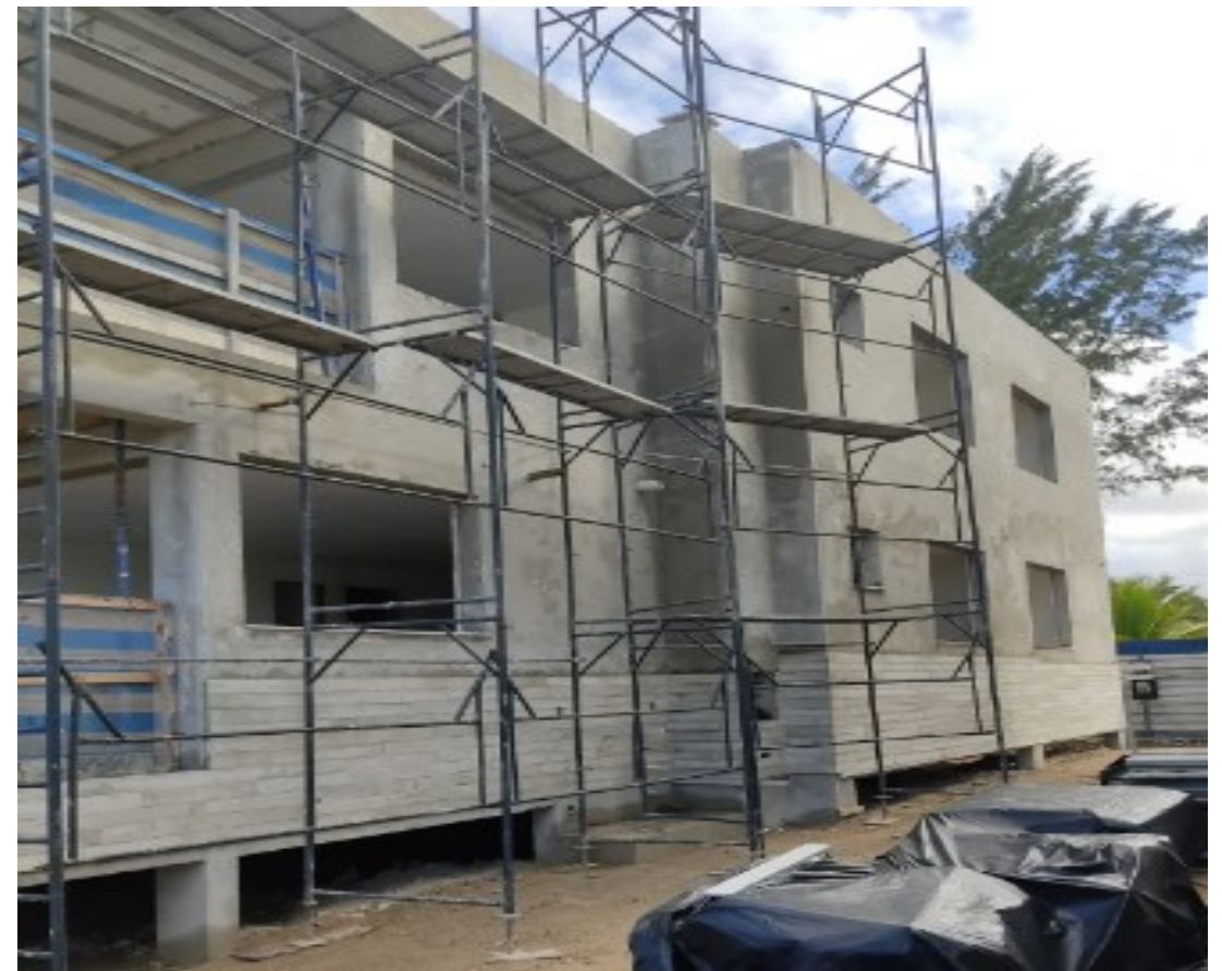
Assentamento de revestimento externo – BL3
