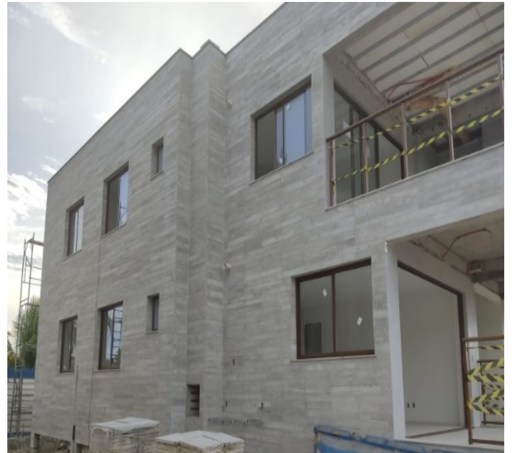
Instalação de esquadrias em BL - 5
